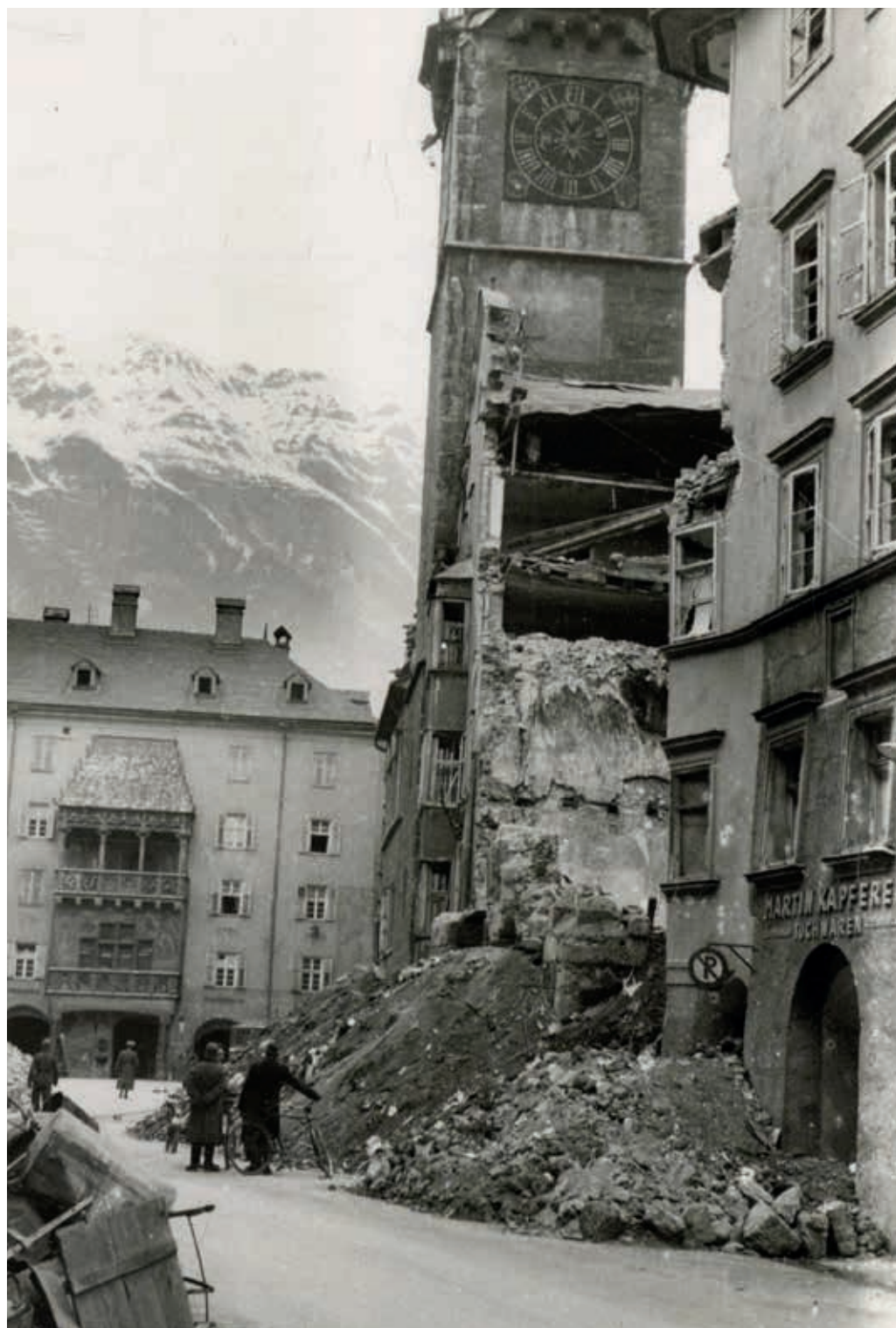
Schäden in der Innsbrucker Altstadt.
