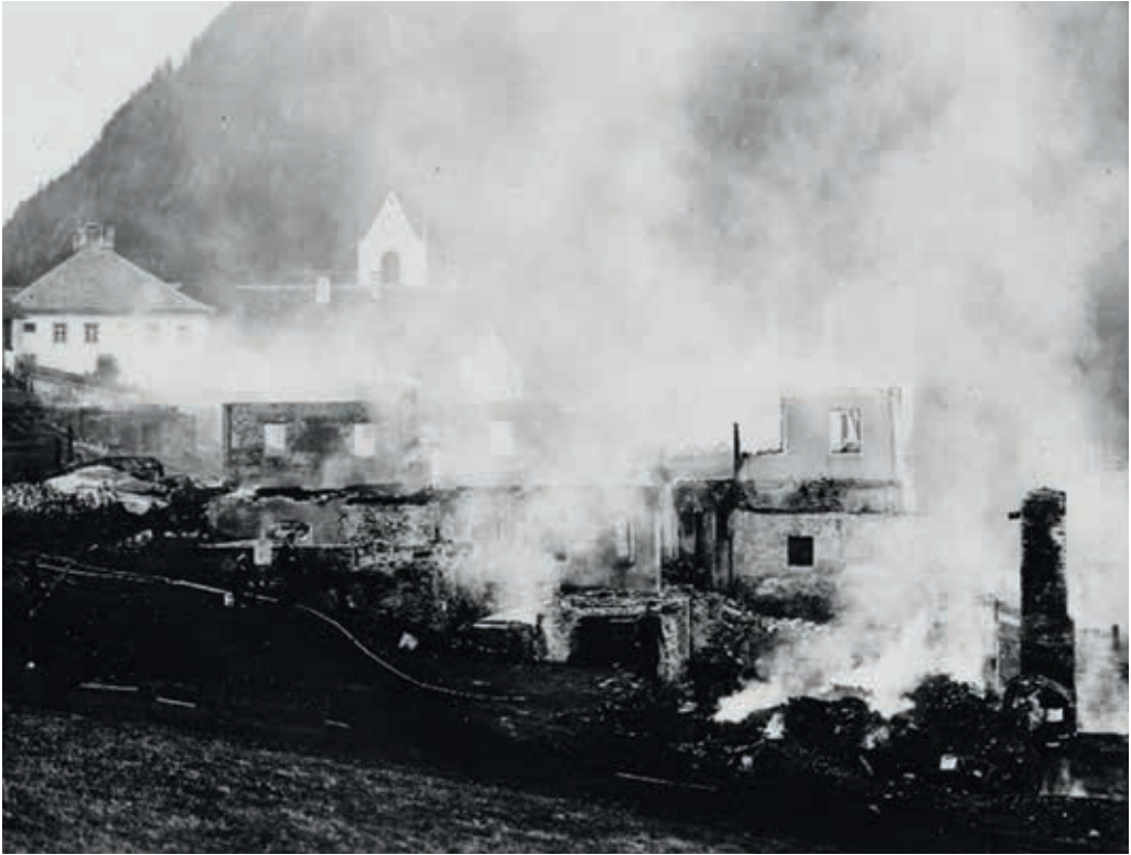
Am 5. und 6. November 1938 äscherte in Hopfgarten i. D. ein Dorfbrand den Dorfwirt, ein weiteres Wohnhaus, zwei Futterhäuser und das Schulhaus ein.
