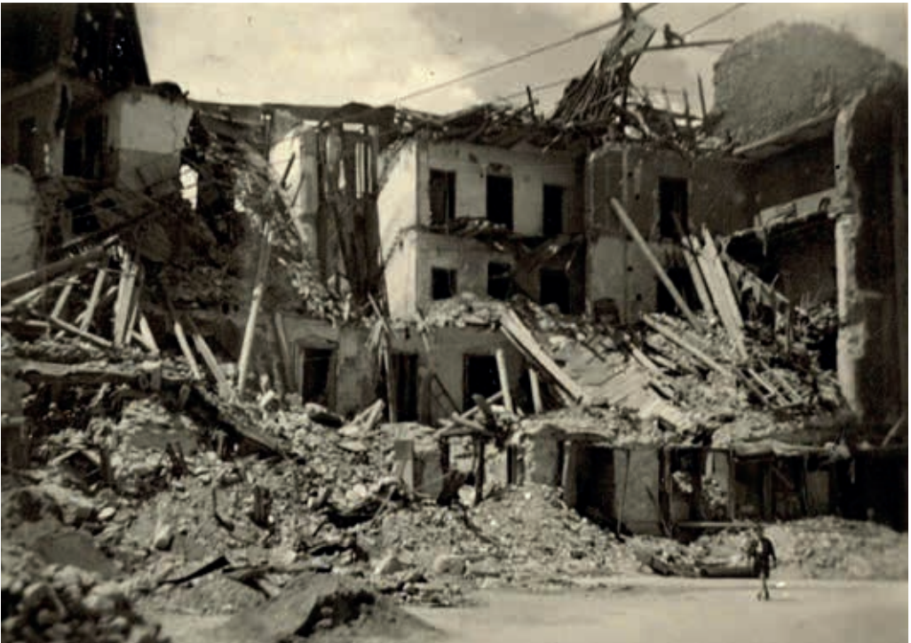
Bombenschäden an der Ecke Boznerplatz/Wilhelm-Greil-Straße in Innsbruck.
