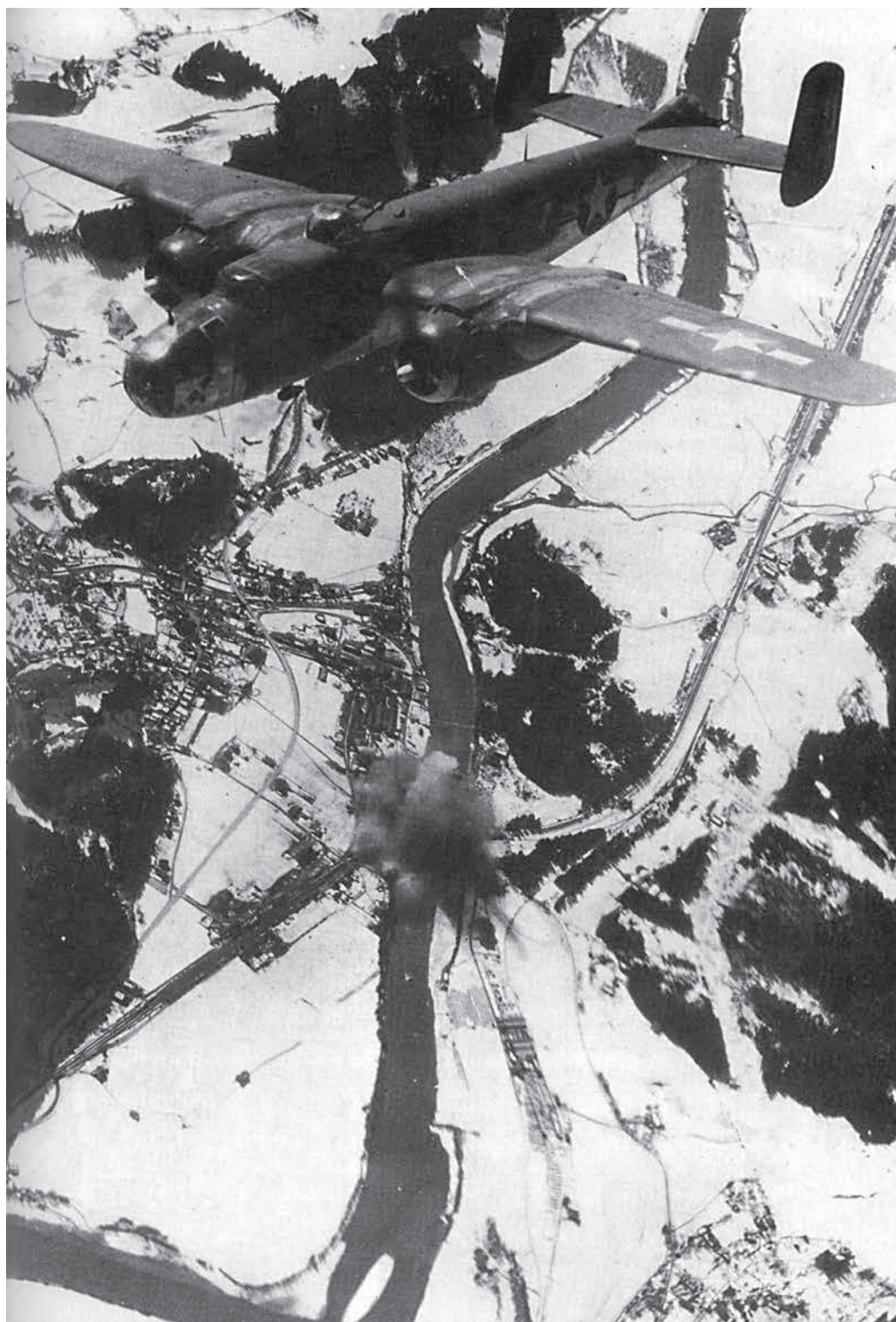
Volltreffer der Eisenbahnbrücke in Brixlegg, 22. März 1945.
